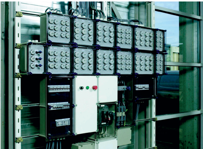
Praktijkvoorbeeld van een schakel- en verdeelinrichting waarbij de drieleidinggroepen met smeltveiligheden kunnen worden gescheiden en voorafgaand hieraan voor het stroomloos maken in de installatie kunnen worden geschakeld. Alleen vakbekwame of voldoende onderrichte personen mogen deze handelingen uitvoeren.
